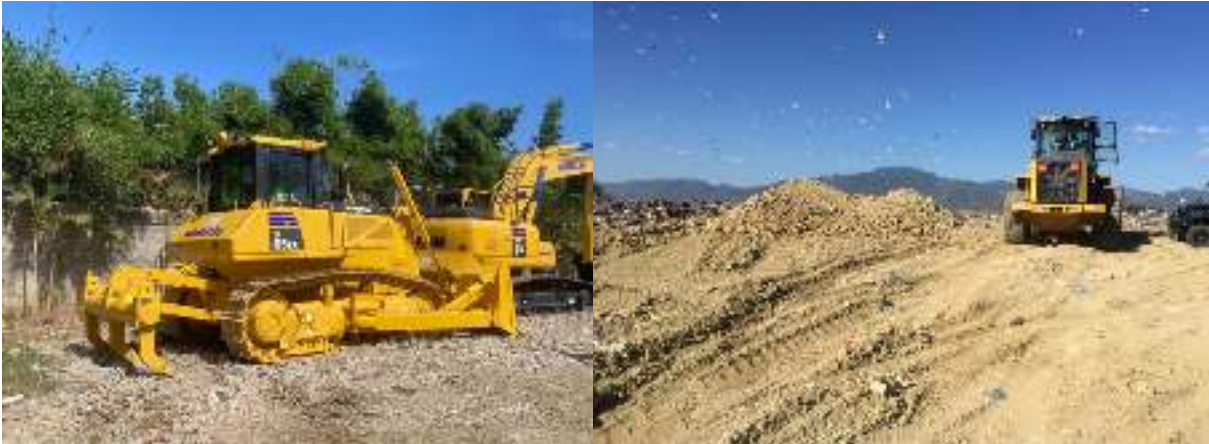
Equipos pesados que se están usando para el manejo del Vertedero Rafey.
