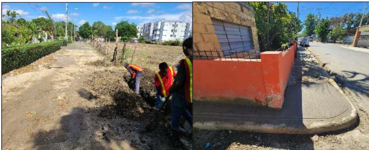
✓ Estatus de ejecución 41%
